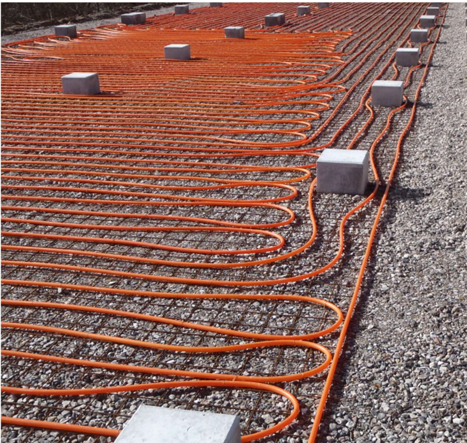
Figur 1 Udlægning af varmeslanger (foto er fra et lignende projekt).
